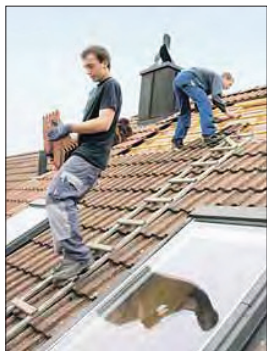
13.00 Uhr: Das Dach wird freigestellt, um die Befestigungslatten zu montieren.
