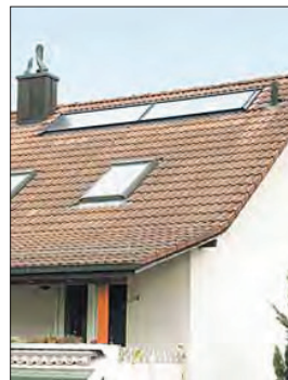
17.00 Uhr: Nach nur einem Tag ist die Solaranlage für Warmwasser samt dem Speicher montiert.
