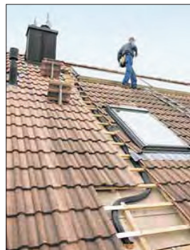
15.15 Uhr: Die Leitung wird fachmännisch verlegt.
